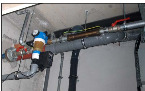
Slika 3–7: Vgradnja AB v hotelu Betnava.
