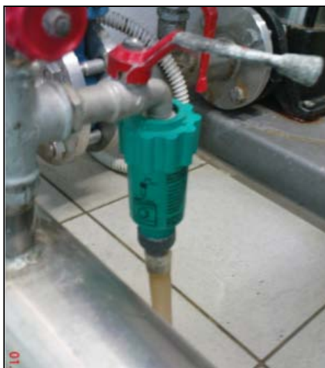
Slika 3–6: Prečpalna postaja in vodohram Rošpoh 2.
